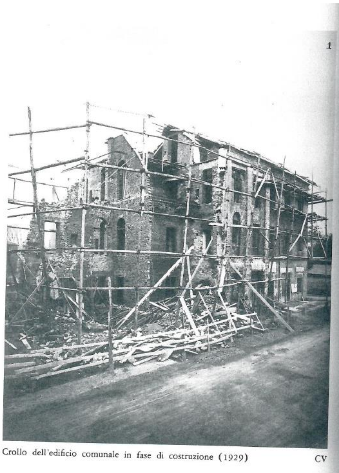
Figura 1 Crollo dell'edificio comunale in fase di costruzione (1929)
